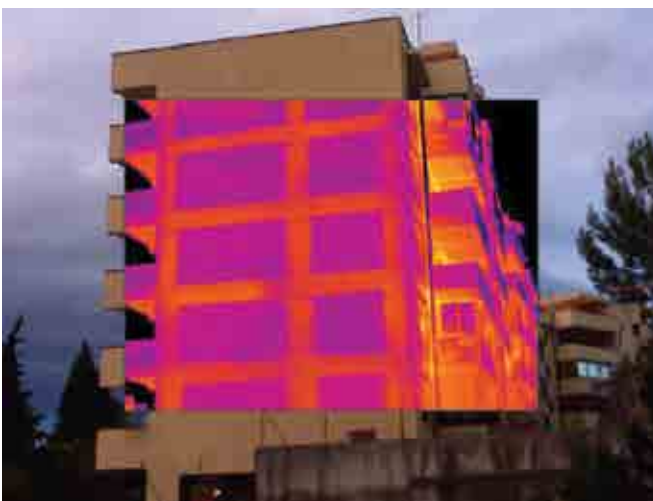
Termografia realizzata alle 6:00 temperatura esterna 20°C
