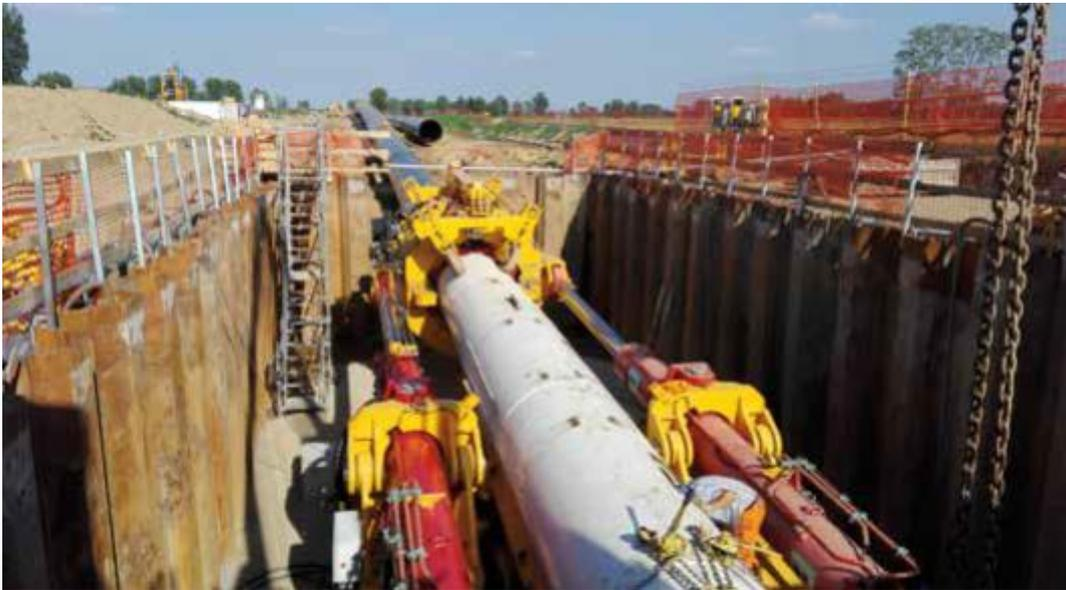
Figura 6.22: Direct Pipe pronto per la fase di spinta [Fonte: SNAM]
