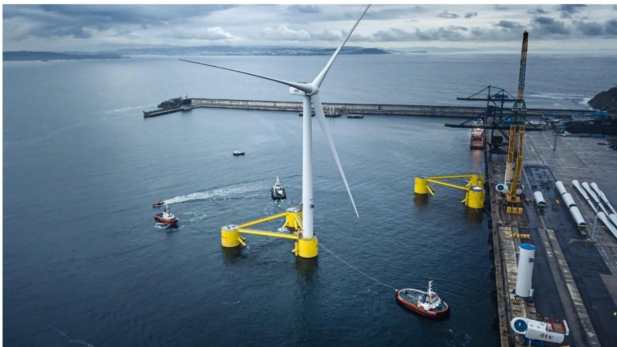
Figura 6.8: Esempio di posa con traino della turbina [Fonte: Global Wind Energy Council]
